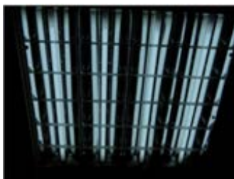
T5-4燈管(900),瓦數 56瓦, 照度900Lux 照明效率7.60, 反射罩效率90%以上
