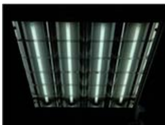
T5-4燈管(600),瓦數 56瓦, 照度600Lux 照明效率5.80, 反射罩效率45%以上
